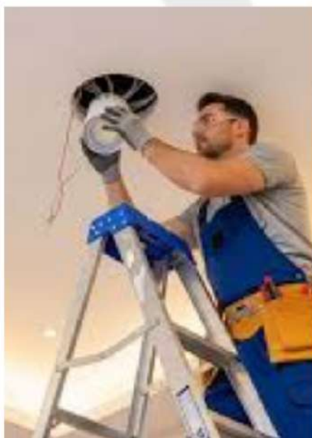
INSTALAR LÂMPADAS E INTERRUPTORES SIMPLES, PARALELO E INTERMEDIÁRIO
