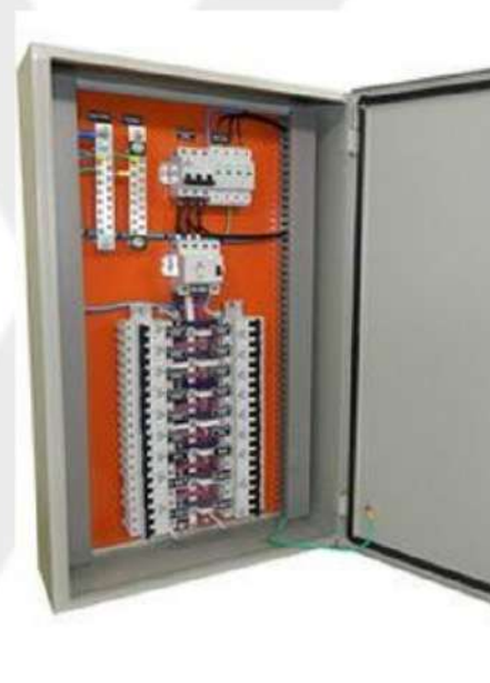
MONTAR QUADRO DE DISTRIBUIÇÃO DE FORÇA E LUZ
